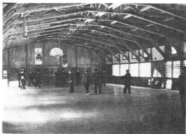
老朽した生徒控所
