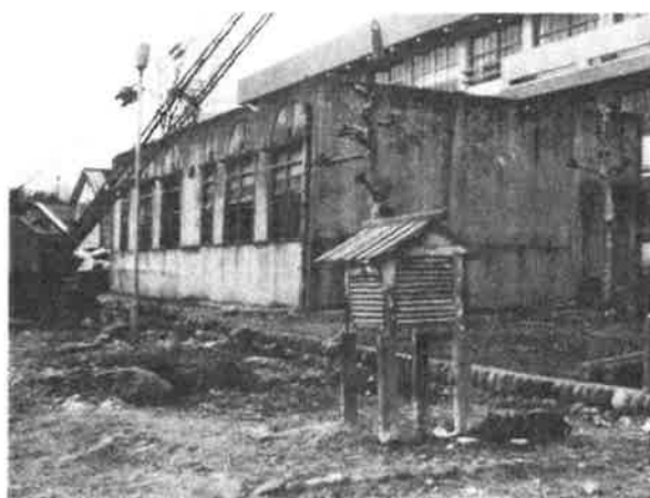
コンクリート校舎の解体 (昭和44年 2月)
