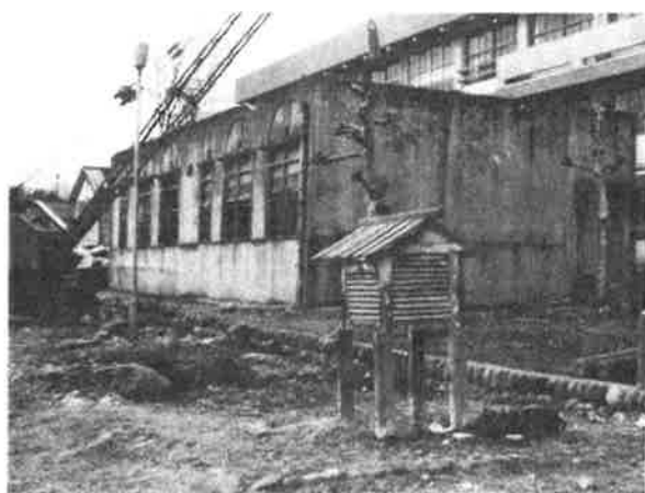
コンクリート校舎の解体 (昭和44年 2月)
